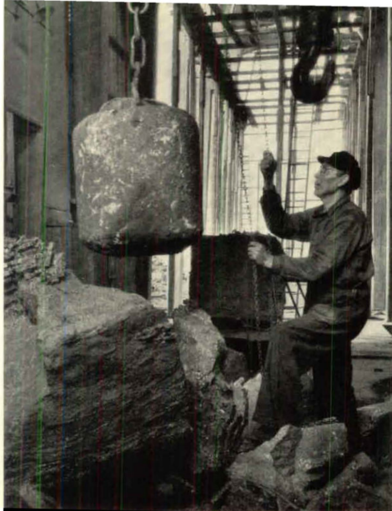
Ovan: Sönderslagare Hilding Persson ställer in fallvikten i lämpligt läge för nästa fall. Efter ett dussintal »smällar» med den 2 ton tunga vikten har Alumosmältan krossats till stycken, lagom stora för nästa krossoperation. Nedan: Två av valsverken i Nya Alumoverkets krosshall.
