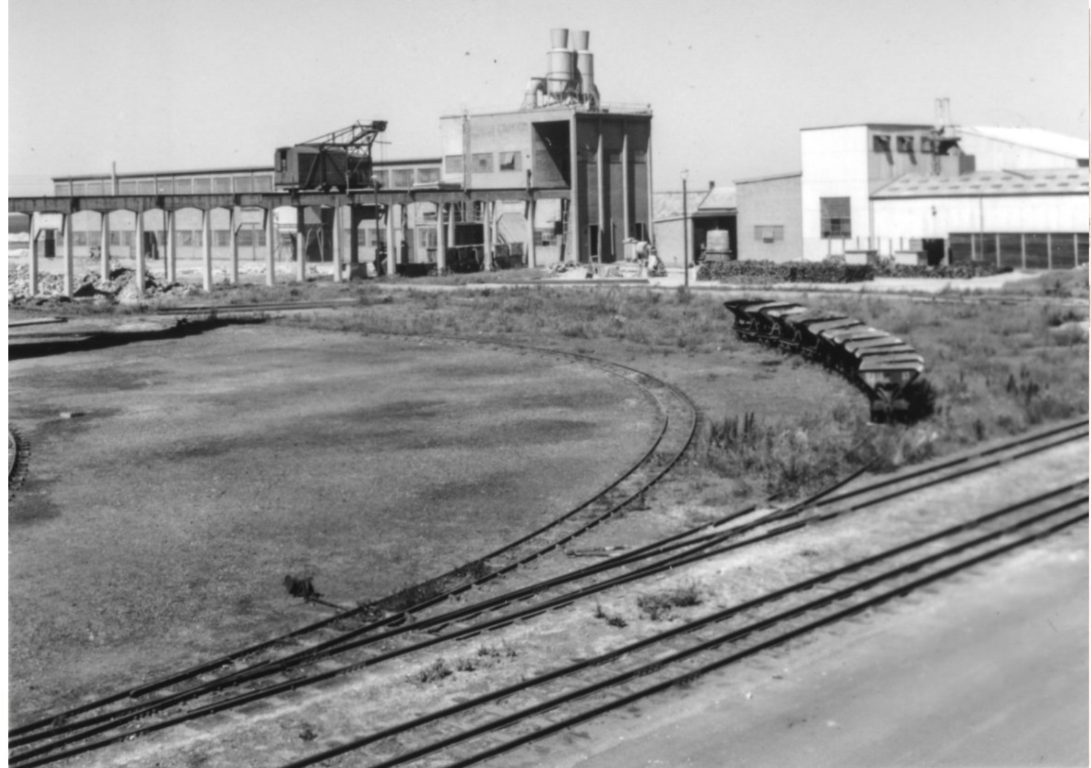
Nya Alumoverket. Med bockkranen håller man just på att lasta in bauxit i fickorna i smälthuset, byggnaden i bildens mitt.
