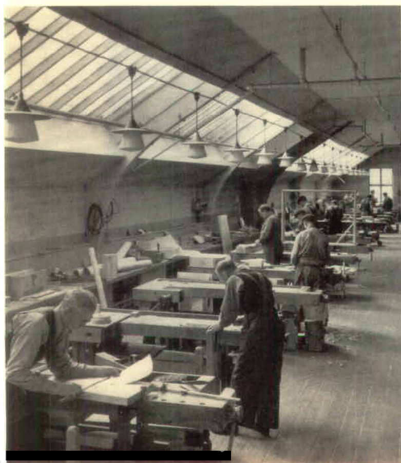
T.v.: Formsnickarna vid sina hyvelbänkar i den ljusa och rymliga snickerisalen på 2:a våningen. I taket synes en del av sprinkleranläggningen med dess munstycken, genom vilka en eventuell brandhärd automatiskt släcks med vatten. T.h.: En av Snickerifabrikens veteraner, Viktor Nilsson, finputsar inlägget i en form.
