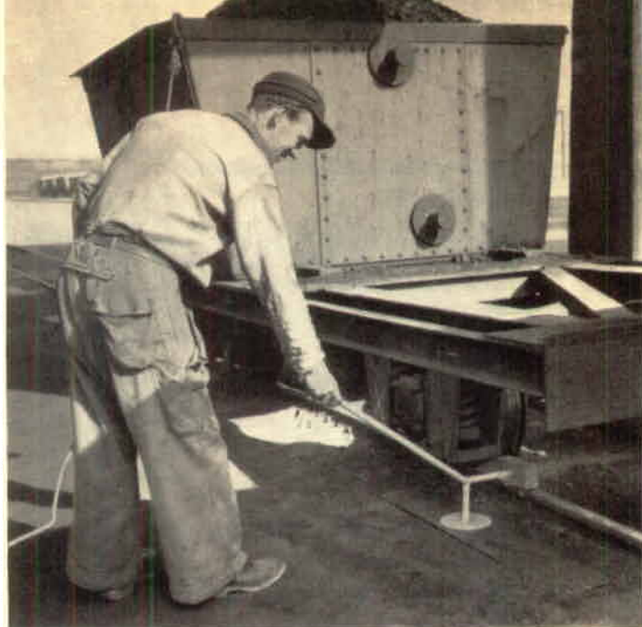
Kranbiträdet Hans Wendler, Höganäs, visar användningen av den nykonstruerade stoppskon med handtag. Praktisk och riskfri.
