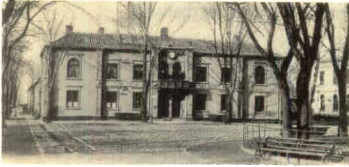
Den byggnad vid Gruvtorget, som på sin tid inrymde Stenkolsbolagets kontor samt Telegrafstation, finns ännu kvar med obetydligt förändrad exteriör. Förekomsten av almräd, kapten Nordenfelts ögonstenar, var som synes riklig.
