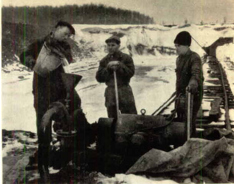
En vintrig bild från Margretebergs lerbrott strax norr om Höganäs. Pumpen har »släppt», Harry Paulsson fyller på vatten i pumphuset för att få sug igen. Tillfälliga åskådare Arvid Karlson och arbetsbasen Algot Holmkvist.
