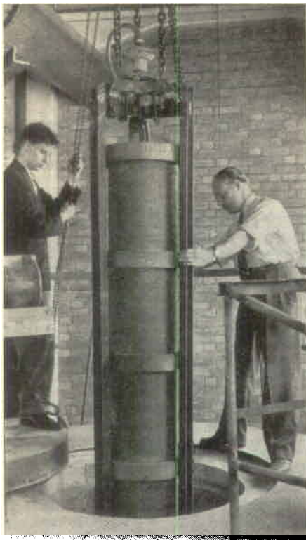
Teknolog Torsten Lonning och förman Allan Karlsson chargerar en försöksugn för järnsvampstillverkning
