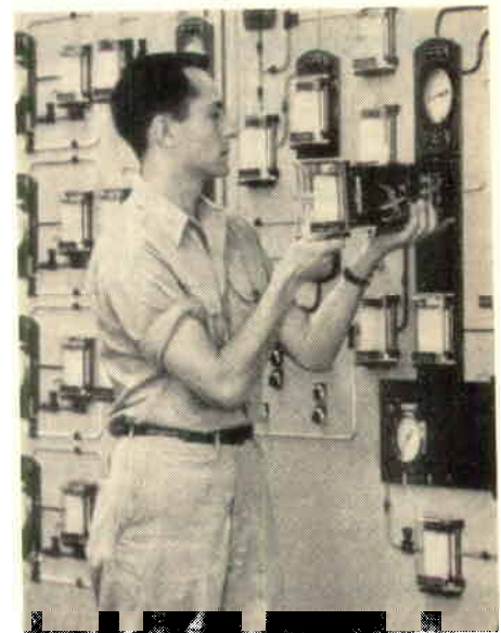
En s.k. grafisk panel, där instrumenten placerats direkt i ett flytschema.
