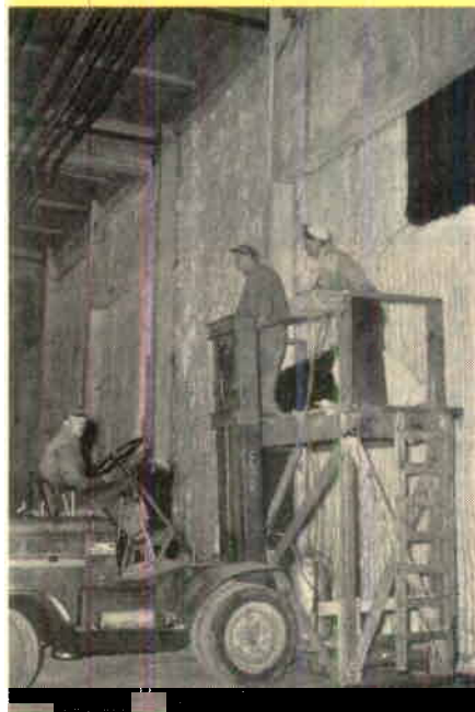
Upptill: Scania-Vabis' nya 400 m 3 lagercistern för tjockolja är isolerad med GLASULLIT. Kloformen ger minsta möjliga yta. — T.v. Rörledningar isolerade med GLASULLIT-skålar är en vanlig syn i källarlokalerna till olika slags byggnader. — T.h. I Hälsingborgs Fryshus har väggar och tak isolerats med glasullsfyll.
