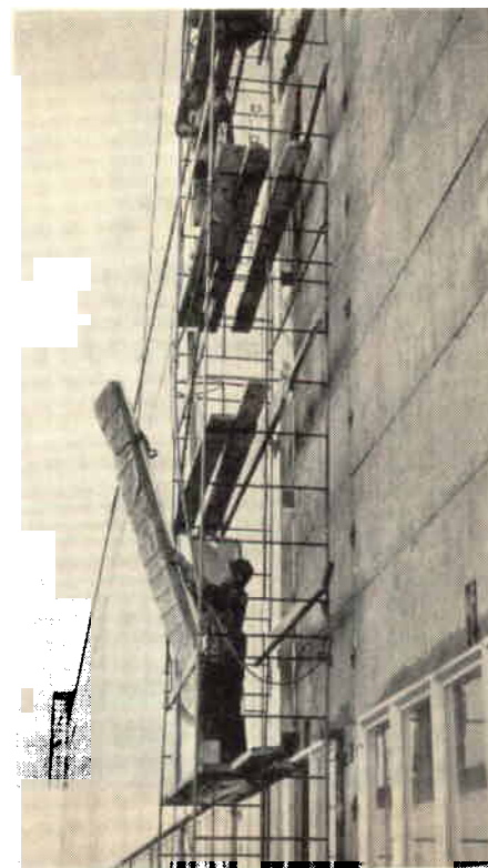
Ovan: Från isoleringsarbetet vid LKAB:s sovringsverk i Kiruna, beläget över trädgränsen. Isolering av 100 mm glasull och 1 mm korrugerad aluminiumplåt fastsköts med hjälp av bultpistol direkt på betongväggen. Nedan: Exempel på villaisolering med GLASULLIT. Betydelsen av en god isolering framgår av att bränslekostnaden för en 1- eller 1½-plansvilla utgör närmare en tredjedel av totala årskostnaden.
