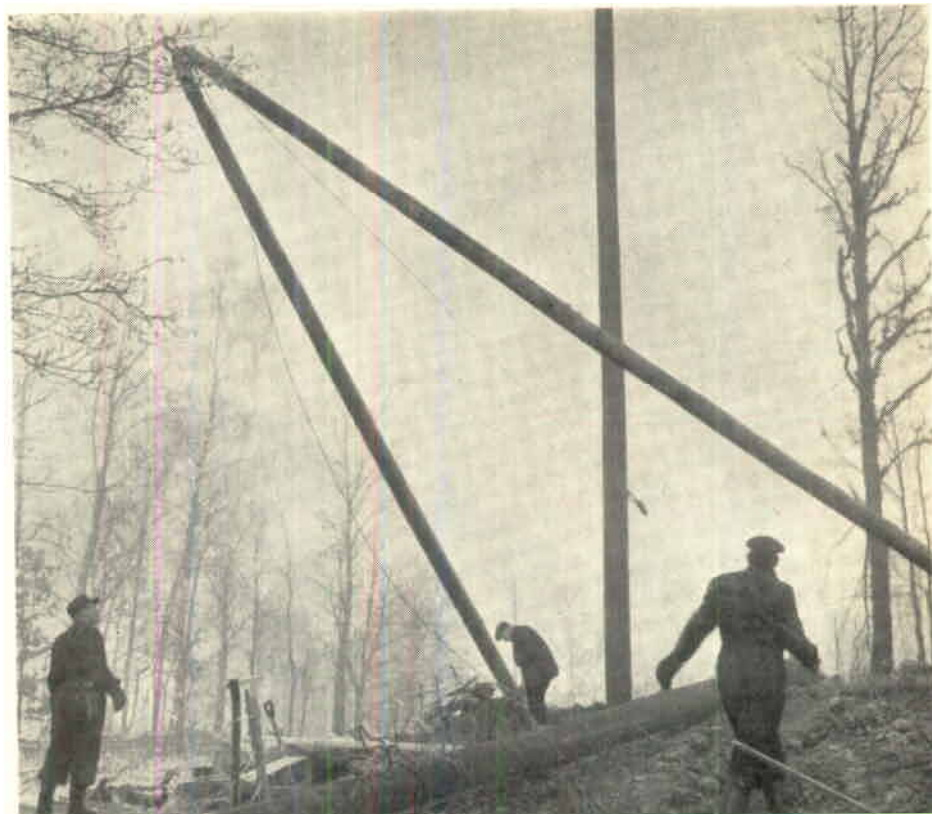
En 50 000 volts linje har påbörjats på sträckan Billesholm—Skromberga. Här är man i lärd med att resa 17-meters stolpar.
