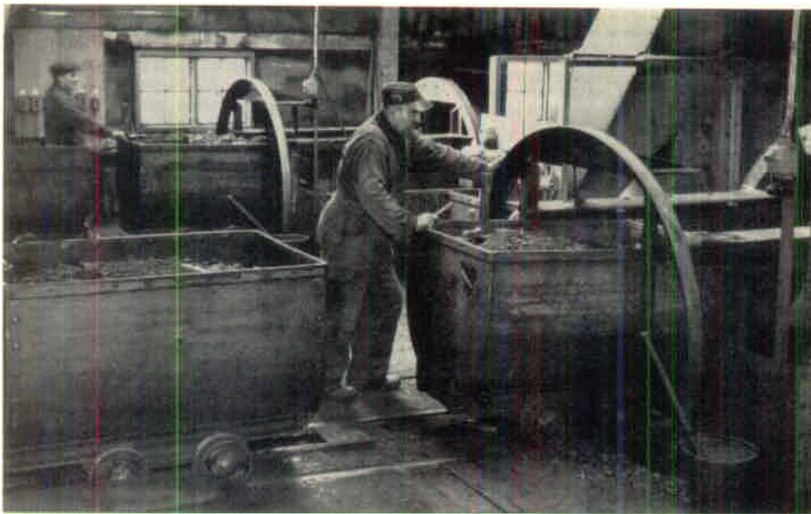
T.v.: När vagnarna har kommit upp ur gruvan, växlas de på gamsen till resp. rundtippare. På bilden är del Erik Bengtsson och Edvin Nilsson, i bakgrunden, som sköter dessa. — T.h.: Arbetsdagen är inte helt slut för gruvfogdarna William Nilsson och Helge Petersson i och med att de stiger ur hissen. På fogdekontoret återstår en del skrivjobb.
