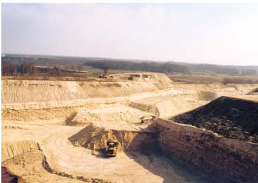
Brytning av kalksten i Ignaberga har pågått sedan 1100-talet. Kalken bröts tidigare i underjordiska gruvor. Ett viktigt miljöarbete för Nordkalk är att återställa naturen efter brytningen.
