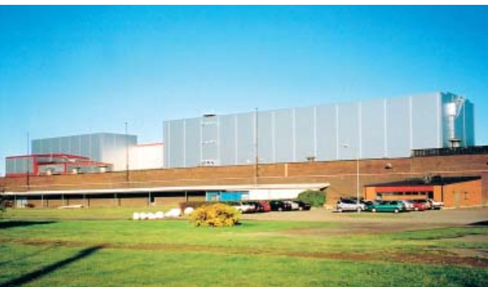
Astaloyverket och Distaloyverket (i bakgrunden) sett från söder. Båda verken har försetts med höga tillbyggnader. Den 27 m höga tillbyggnaden på Distaloyverket rymmer den nya blandningshallen
