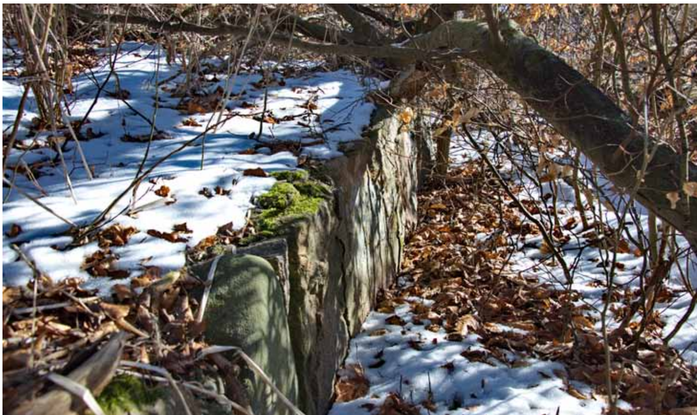
Grundmur från fabriksbyggnad. Möjligtvis har muren återanvänts för senare verksamhet..
