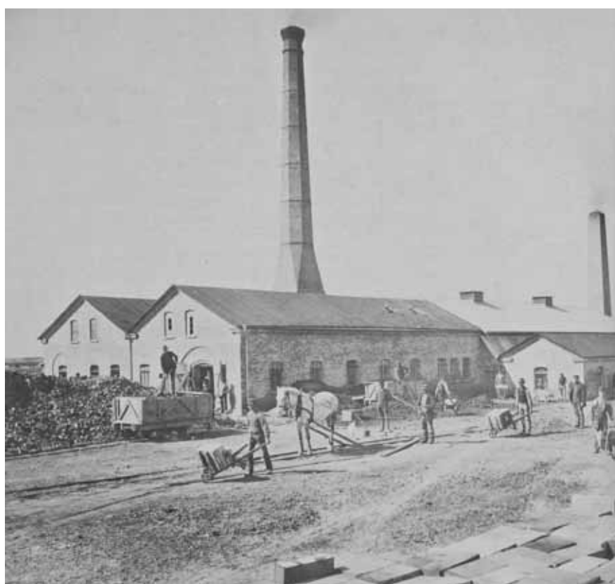
Två bilder på tegelverket. Den övre från ca 1870 (före branden 1881) och den undre från Högnäsbolagets tid efter uppbyggnad av fabriken 1889.
