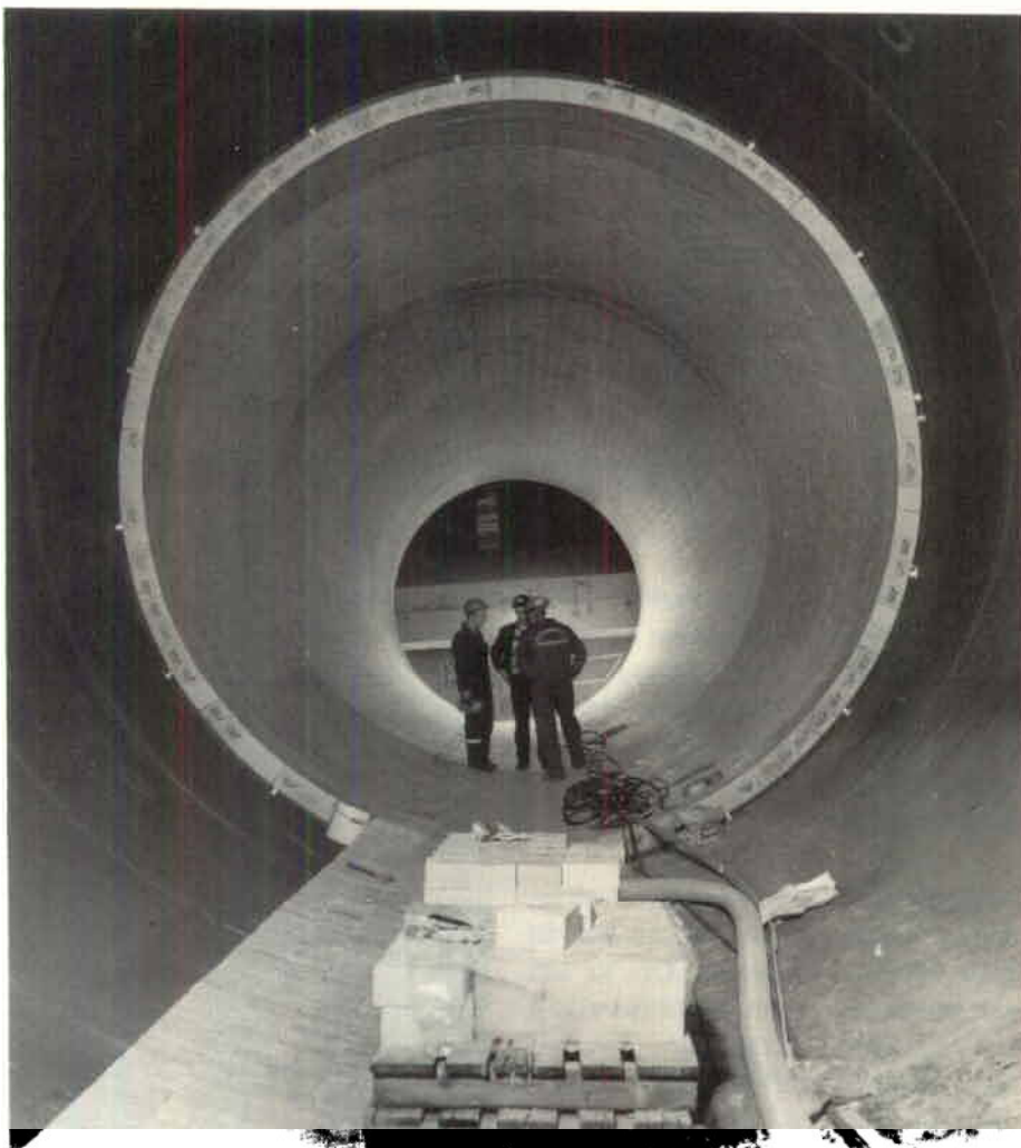
Torsten Persson, arbetsledare vid Höganäsarbeten, i samspråk med Olle Klippmark och Folke Nilimaa, LKAB, i en färdigmurad del av den 34 meter långa roterugnen i kulsinterverket.
