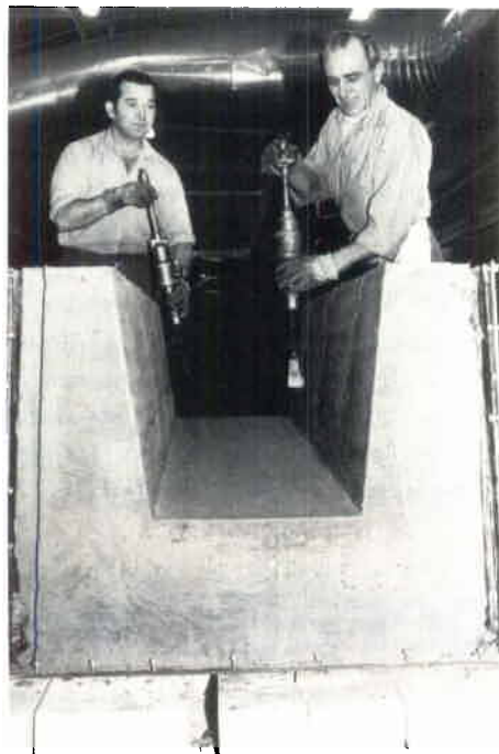
– Så här gjorde vi, berättar Ference Horwath och Valdemar Bredborg, när de stampade 2,5-tonsteglet.
