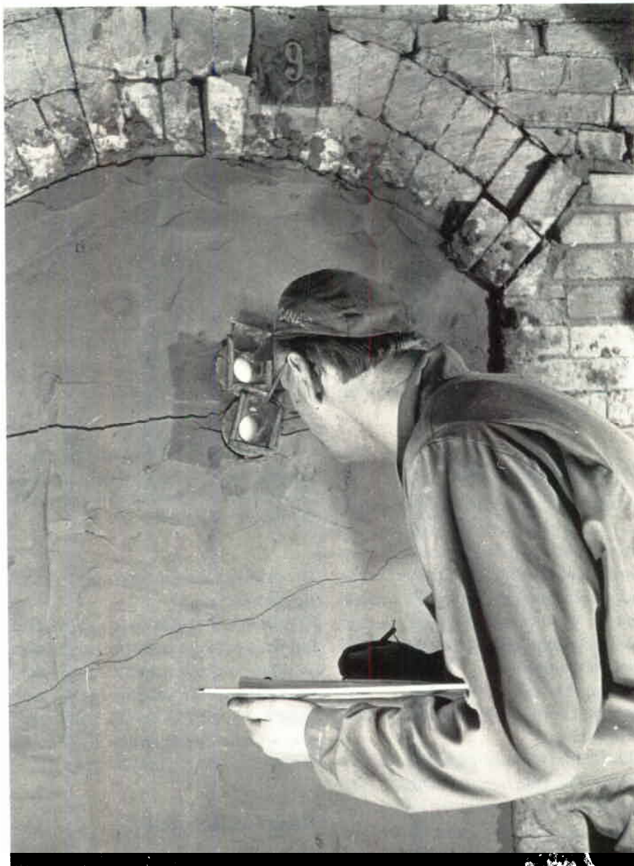
Genom hålet i den igenmurade porten till ugnen kan brännförloppet kontrolleras. Här utförs kontrollen av Bertil Persson.
