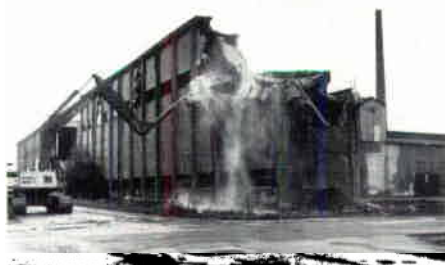
Inte hela, men väl en del av "rasket" rivs. Här är det högdelen på gamla järnsvampverket som faller för grävskopan.
