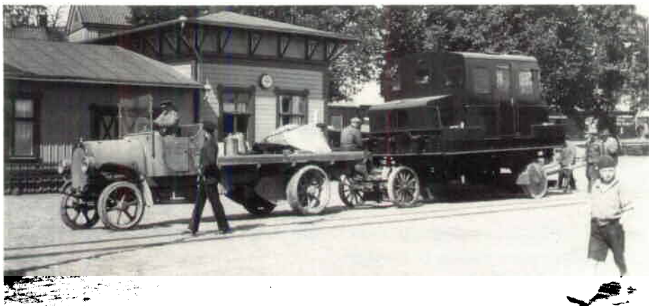
Ett växellok på väg till stationen, förmodligen sent 20-tal. Lägg märke till den kedj drivna lastbilen och männen bakom som hjälper till att putta på.
