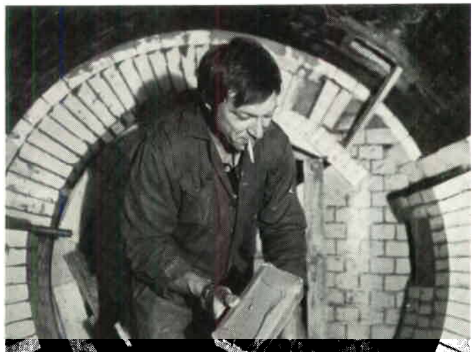
Att vara eldfast murare betyder att man ibland måste vara beredd på att arbeta i svåra arbetsställningar. Här ser vi Tommy Rundström mura ett valv i en förvärmare i Ignaberga.
