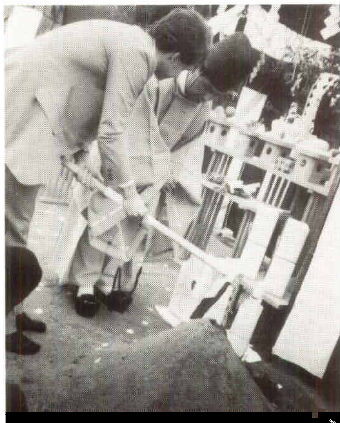
Rune Pettersson tillsammans med shintoprästen, tar ett symboliskt spadtag inför byggstarten av blandningsstationen.
