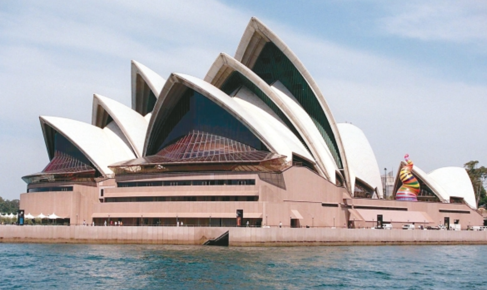
Australiens mest moderna byggnad är Sydney operahus. Taket är klätt med keramikplattor med transparent glasyr, som har tillverkats av Höganäsbolaget. Keramikplattorna täcker 17000 kvadratmeters takyta, vilket motsvarar två fotbollsplaners storlek.
